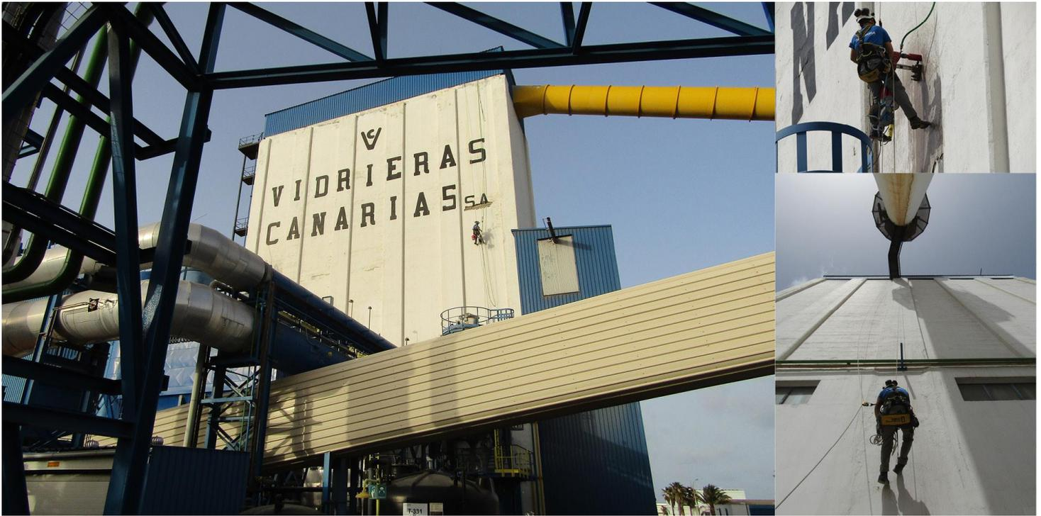
Se han encargado a FHECOR Ingenieros Consultores los trabajos de inspección y diagnóstico de la estructura de los silos de almacenamiento de Verallia en Telde, Gran Canaria, en los que se acopian los diferentes materiales necesarios en el proceso de fabricación de recipientes de vidrio para distintos productos alimentarios y bebidas.
